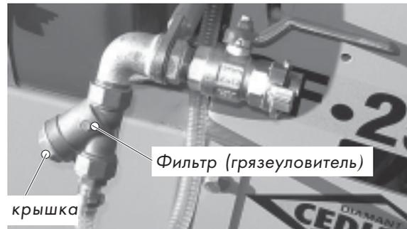
CF•2500 D, Грязеуловитель под компактной маслостанцией, правая защитная крышка снята
